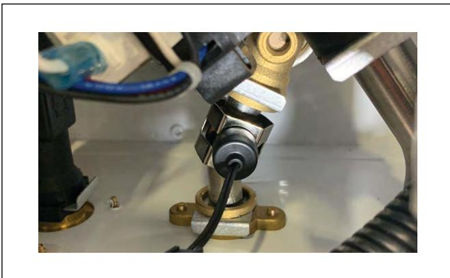
Figure 43 DHW Sensor
